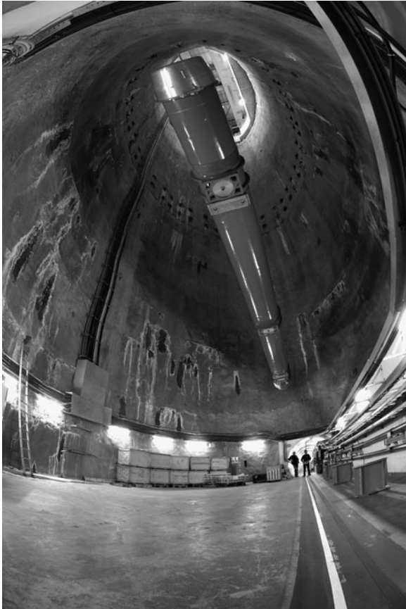
ABB. 5.6 Ein LHC-Dipolmagnet wird in den Tunnel hinabgelassen Quelle: CERN.
