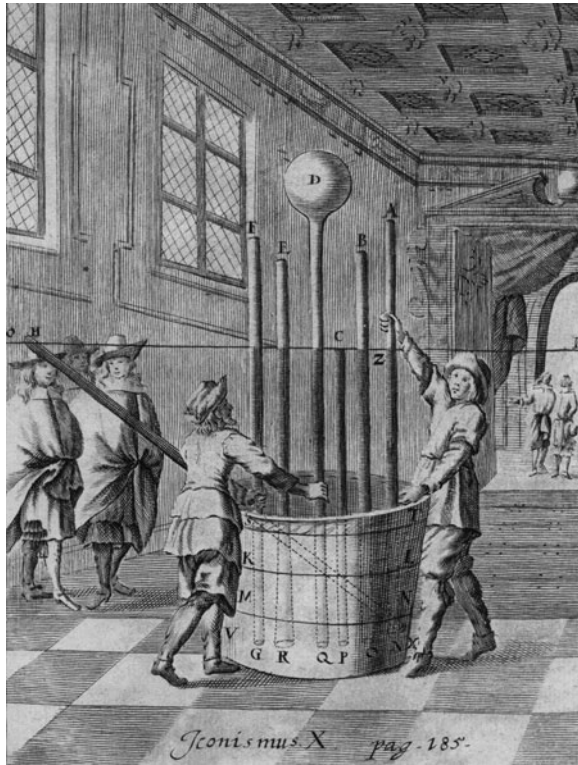
ABB. 7.6 Torricellis Experiment zur Widerlegung des horror vacui : Ungeachtet der Länge der leeren Röhrenabschnitte fallen die Quecksilbersäulen in allen Röhren auf dieselbe Höhe Quelle: Abteilung für Fotografie, Institut und Museum für Wissenschaftsgeschichte, Florenz/ Aufnahme: Eurofoto.
