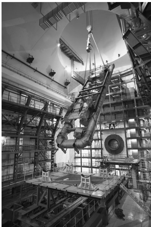
ABB. 6.9 Am 26. Oktober 2004 schwebt die erste supraleitende Magnetspule in die Halle des ATLAS-Detektors
